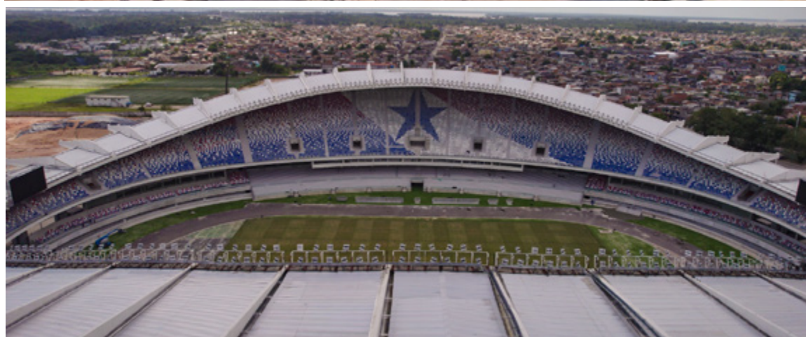
Obras do novo Mangueirão.
