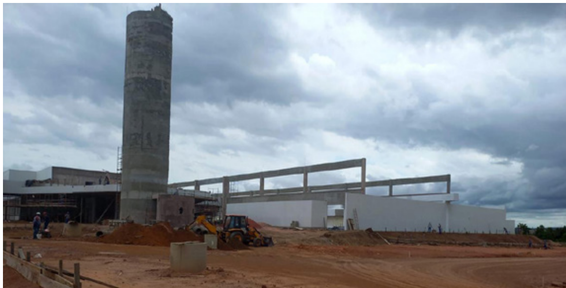
Execução dos serviços do Centro de Convenções, em Santarém.
