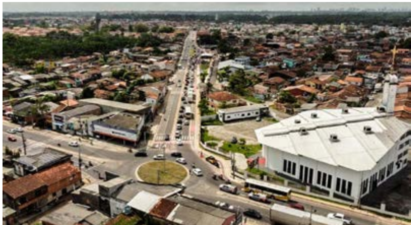
Reconstrução da Av. Padre Bruno Sechi, no bairro do Bengui, em Belém.
