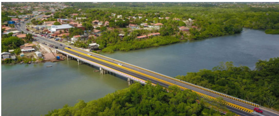
Construção de ponte em concreto armado sobre o rio Acará-Miri, no município de Tomé-Açu.
