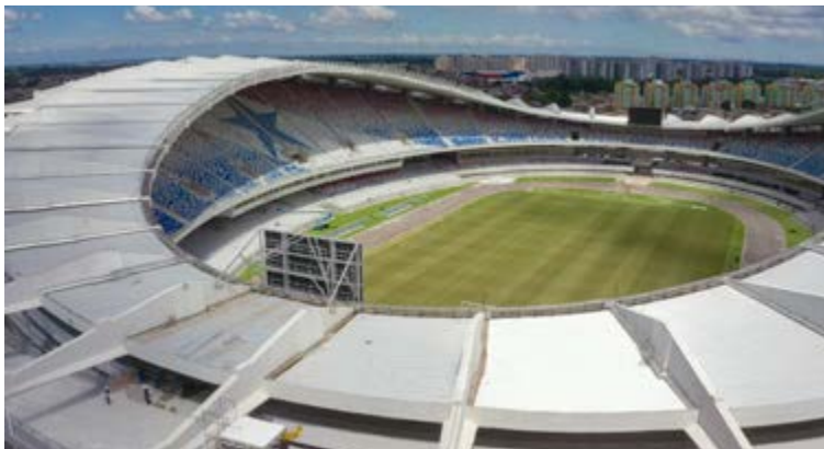
Obras do Estádio Olímpico do Pará – Mangueirão.
