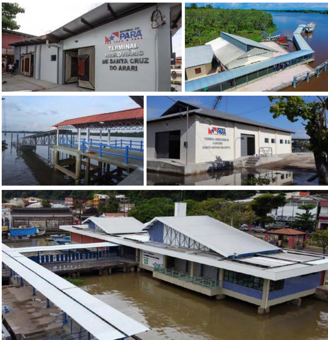
Terminais Hidroviários de Santa Cruz do Arari, Santana do Tapará, Ponta de Pedras, Alenquer e Monte Alegre.
