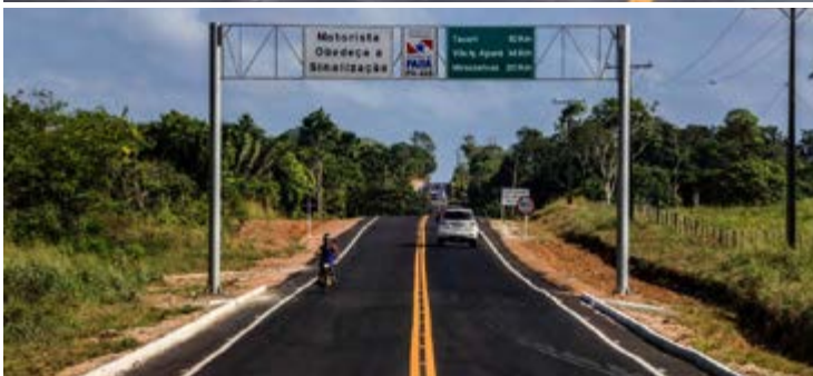
Pavimentação da PA-407 (Rodovia do Açaí) e da PA-448.
