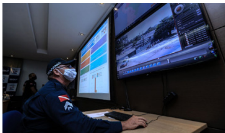
Câmeras de videomonitoramento e Núcleo Integrado de Operações de Altamira; e sistema de videomonitoramento, em Breves.
