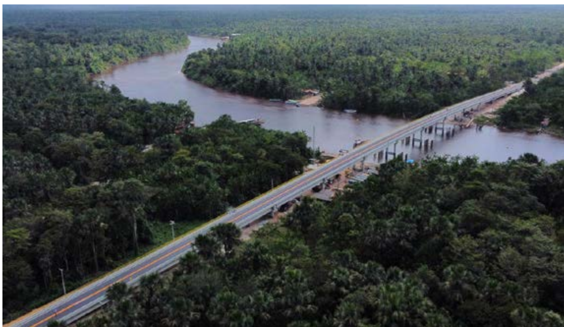
Ponte do rio Meruí.
